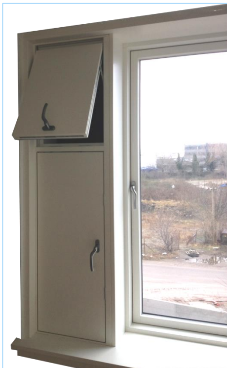
Figur 6. Løsning, hvor ventilationsvinduet er etableret som et selvstændigt felt uden vinduesglas. Det giver mulighed for at arbejde med en særligt effektiv lydsluse. Ved brug af denne løsning skal man sikre, at det egentlige vindue har en høj lydisolation. Bemærk, at det egentlige vindue kan åbnes. I så fald er det naturligvis ingen ekstra støjdemping. Kilde: Kastrupvinduet.
