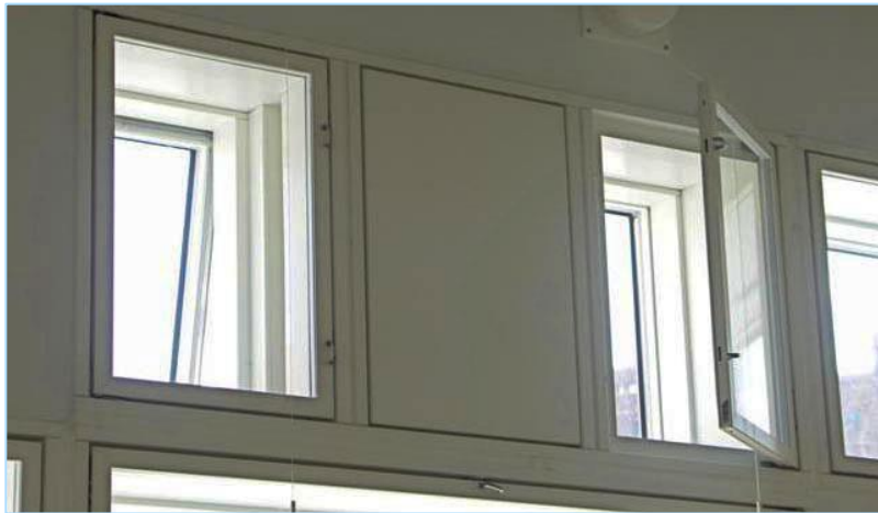
Figur 5. Principløsningen på Figur 3 er her anvendt i en konkret løsning. De to lukkede vinduer på billedet skal have en passende høj lydisolation for, at denne løsning har den ønskede effekt. Det er muligt at åbne alle fire vinduer for at få maksimal udluftning. I så fald er vinduets støjdemping som for almindelige vinduer.
