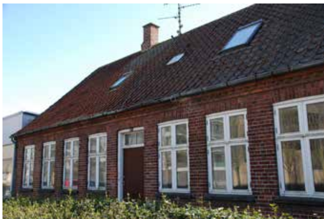
Havnevej 46 - facade mod Havnevej
