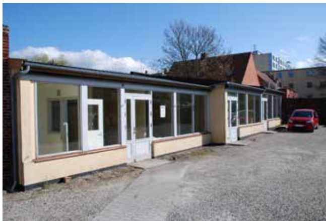
Havnevej 46a - uisolerede lagerlokaler i gård
