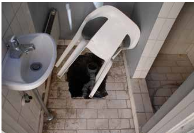
Havnevej 48 - toilet og baderum i gården
