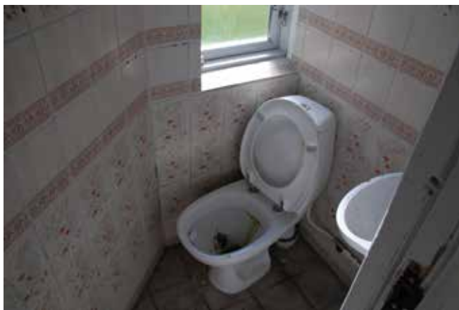
Havnevej 46 - Fælles toilet og baderum i tilbygning
