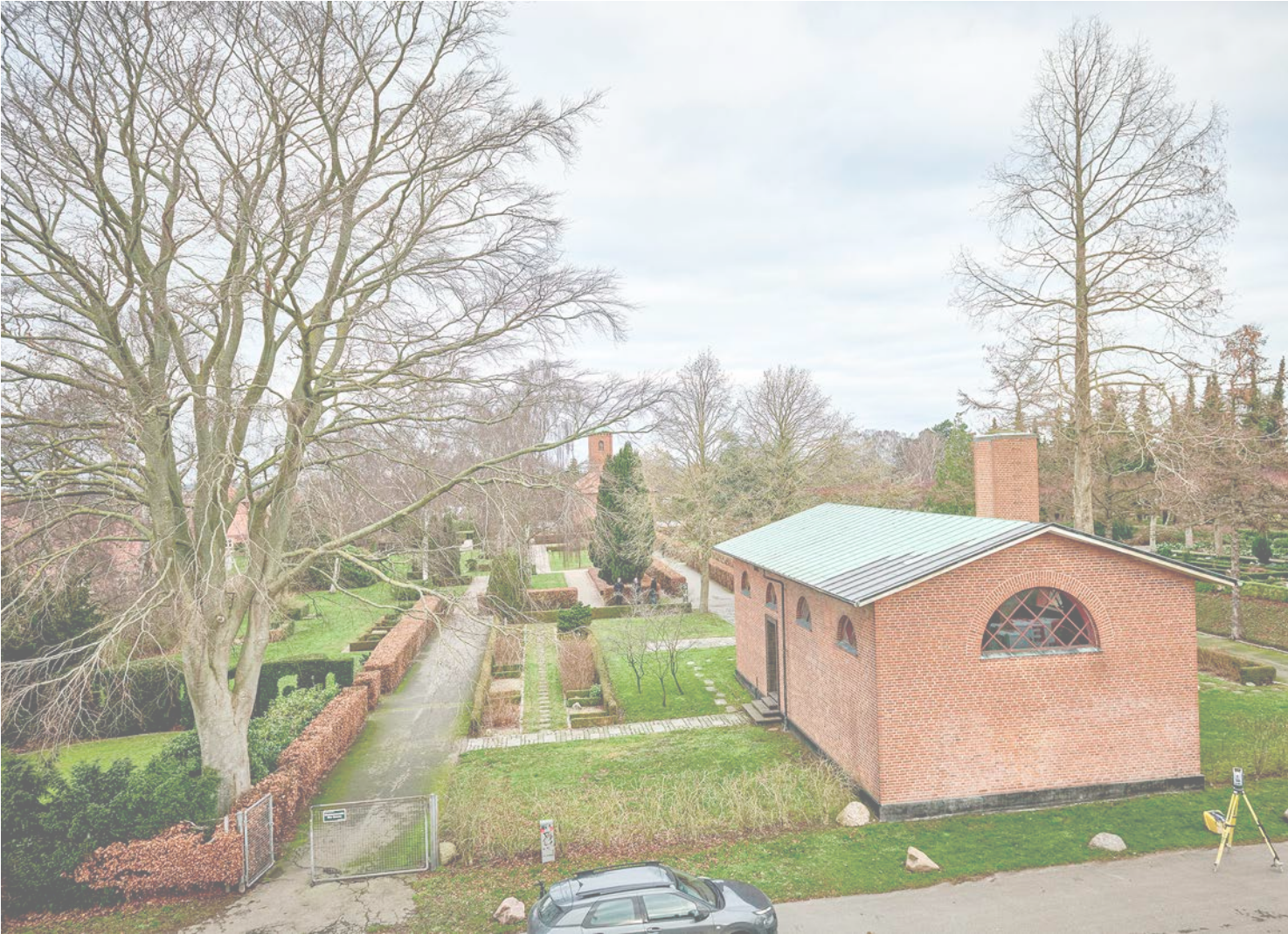
View fra 3. etage fra byggefelt 9
