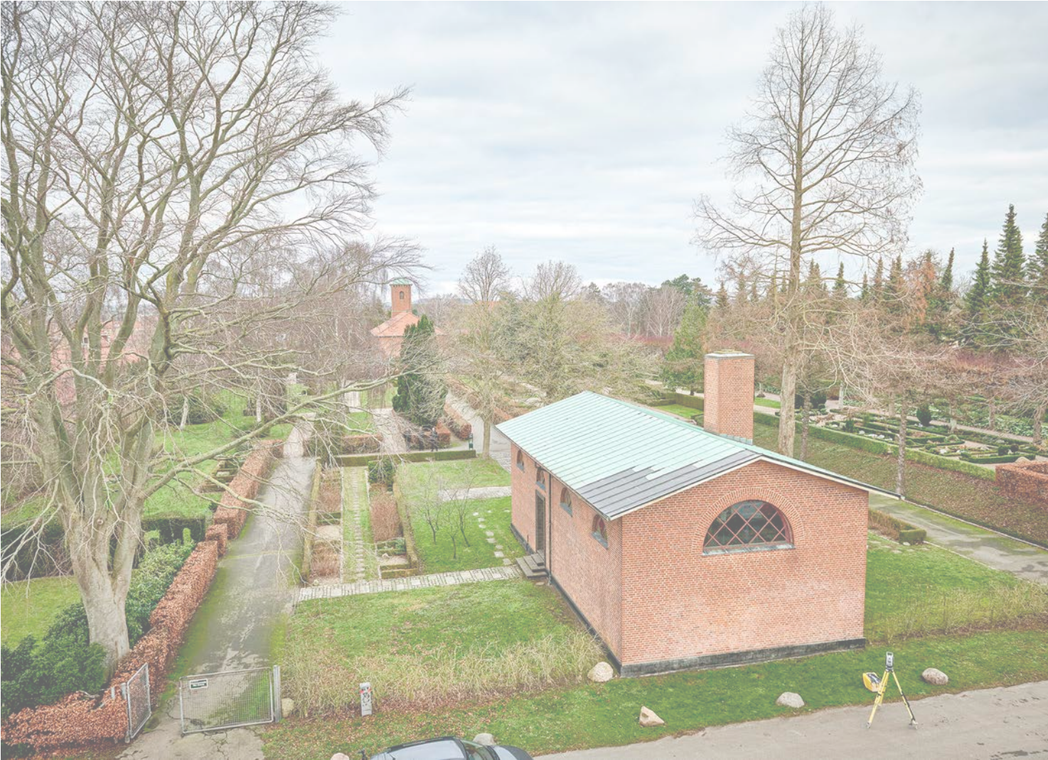
View fra 4. etage fra byggefelt 9
