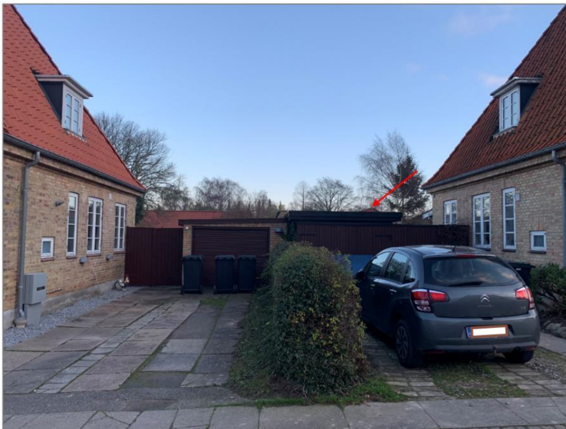
Foto 10 Foto taget af Byggeudvalget fra en position midt på Godthåbsvej
