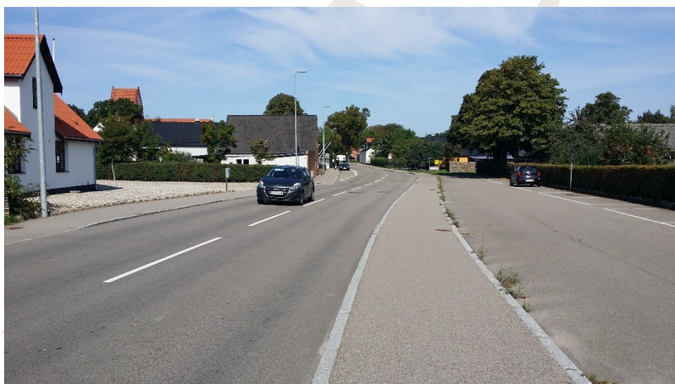
Figur 3-8 Lokalvej med parkeringspladser ved Udbyvej nr. 34 - 36 set mod nord. Foto: COWI
