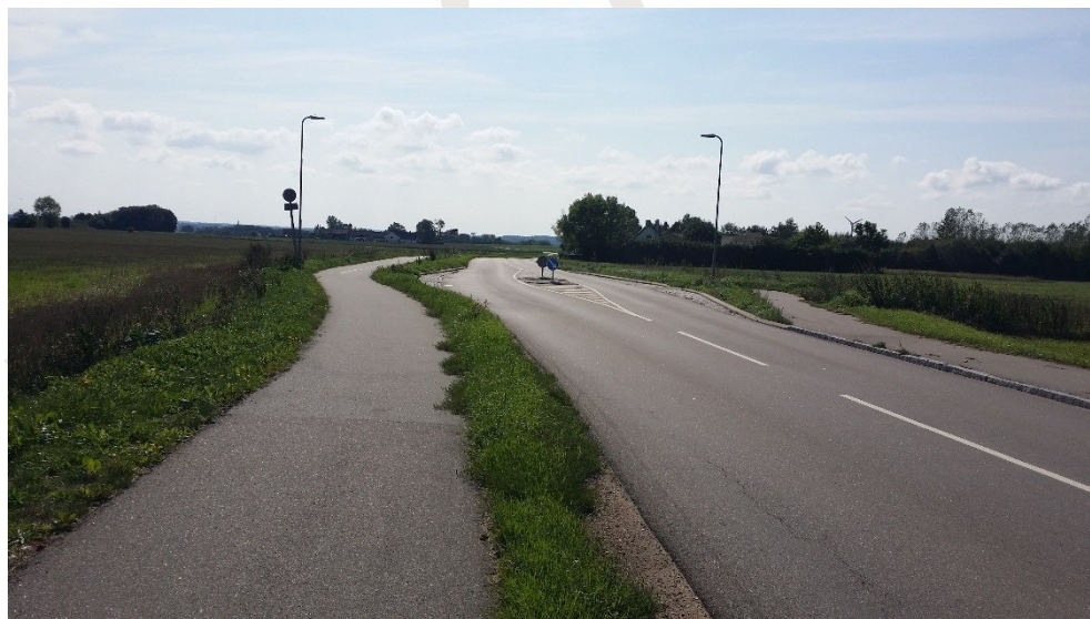
Figur 3-6 Udbyvej ved stikrydsningen set mod syd. Foto: COWI
