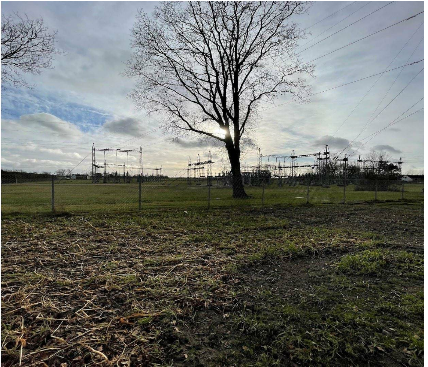
Billede 5: Eksisterende transformerstation set fra nord. Lokalplanområdet følger vest for samt umiddelbart nord for.
