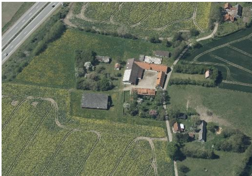
Figur 8-5: bevaringsværdige bygninger på Langerød 5, 4300 Holbæk (Styrelsen for Dataforsyning og Infrastruktur.)
