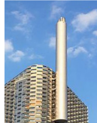
Skorsten som en del af den nye silhuet
