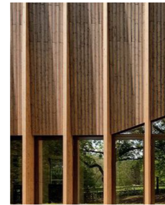
Træfacade med begrænset mængde glas
